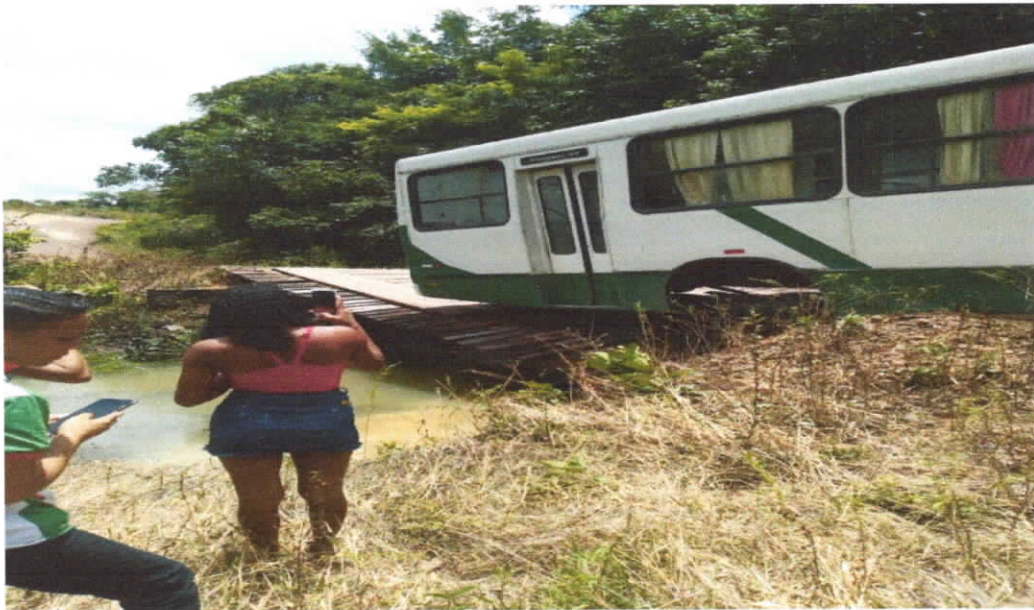
Foto 08 - Construção de ponte com cravação de estacas
