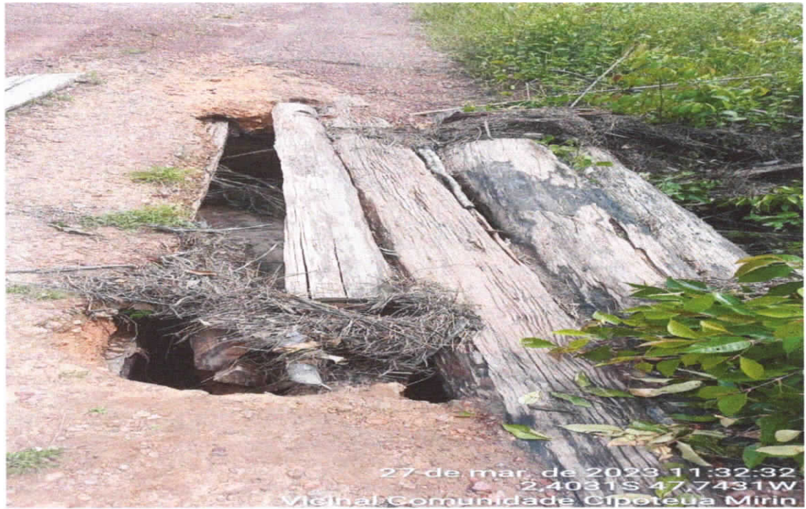
Foto 02 - Corrego na Vicinal Cipoteua Mirim - Tubulação Tb-120
