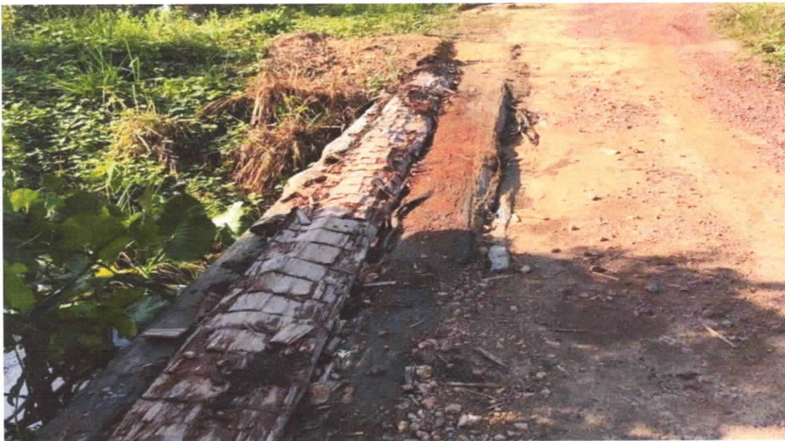
Foto 06 - Revitalização da ponte
