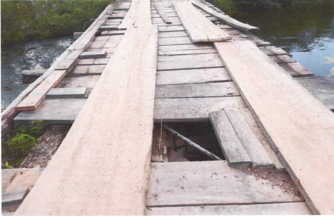
Foto 07 - Construção de ponte com cravação de estacas
