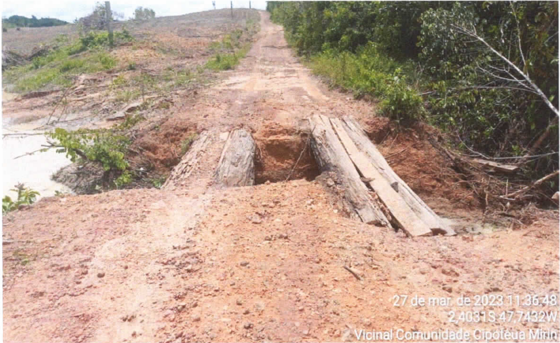
Foto 04 - Corrego na Vicinal Cipoteua Mirim (3) - Tubulação Tb-100
