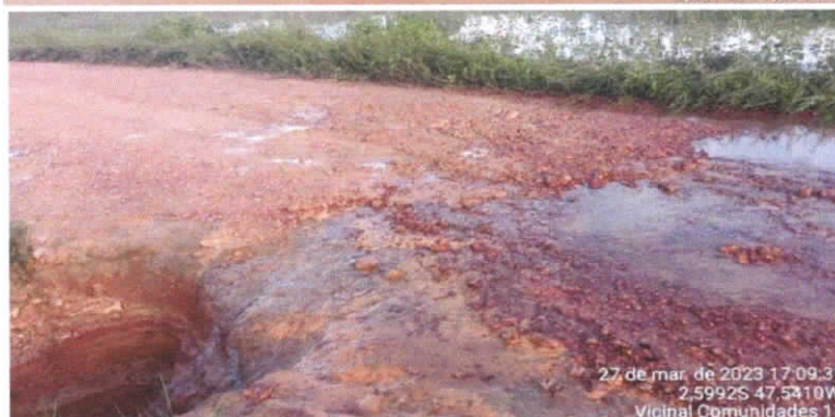
Foto 12 – Tubulação de 600 e 1200 mm
