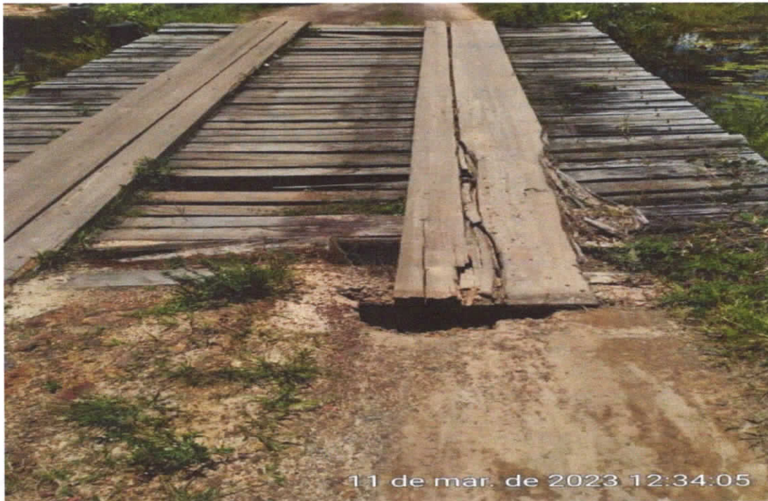
Foto 09 – Construção de ponte com cravação de estacas
