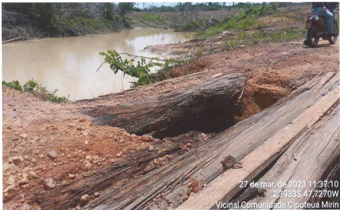
Foto 03 - Corrego na Vicinal Cipoteua Mirim - Tubulação Tb-120
