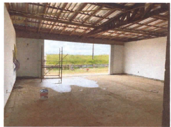
FOTO 6 – VISTA INTERNA DA ENTRADA DO PRÉDIO
