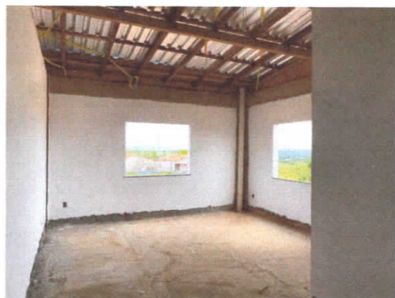
FOTOGRAFIA 11- VISTA INTERNA DO PRÉDIO
