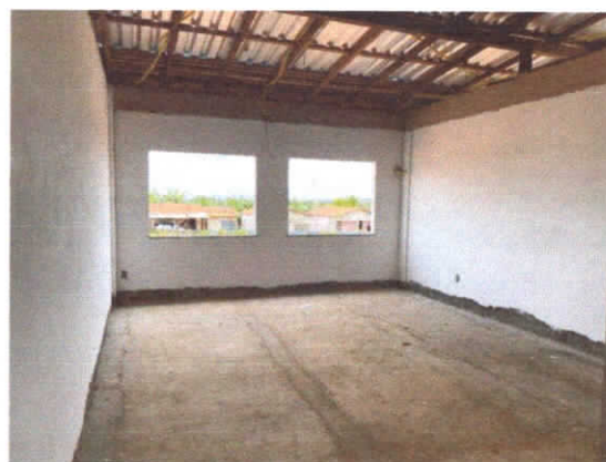
FOTOGRAFIA 10- VISTA INTERNA DO PRÉDIO
