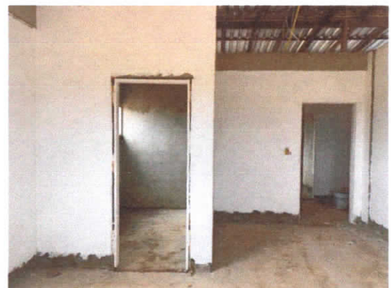
FOTO 8 - VISTA INTERNA DO PRÉDIO
