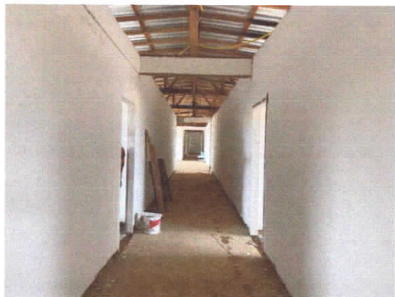
FOTOGRAFIA 9- VISTA INTERNA DO PRÉDIO
