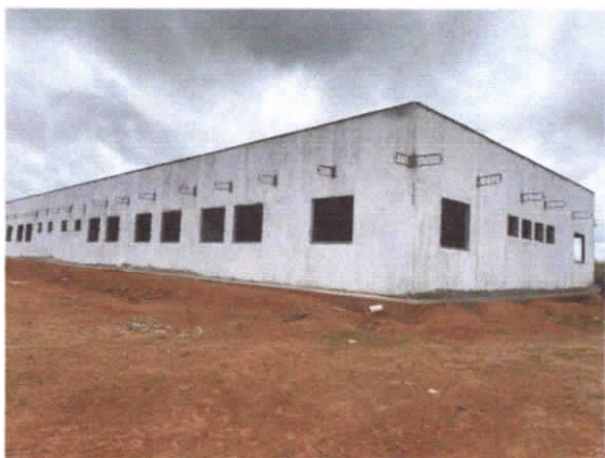
FOTO 5 – VISTA TRASEIRA DO PRÉDIO
