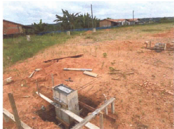
FOTO 4 – CONCRETAGEM DAS SAPATAS DO GALPÃO
