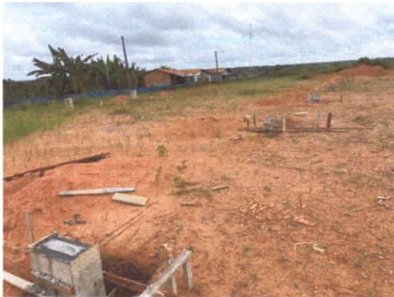
FOTO 3 – CONCRETAGEM DAS SAPATAS DO GALPÃO
